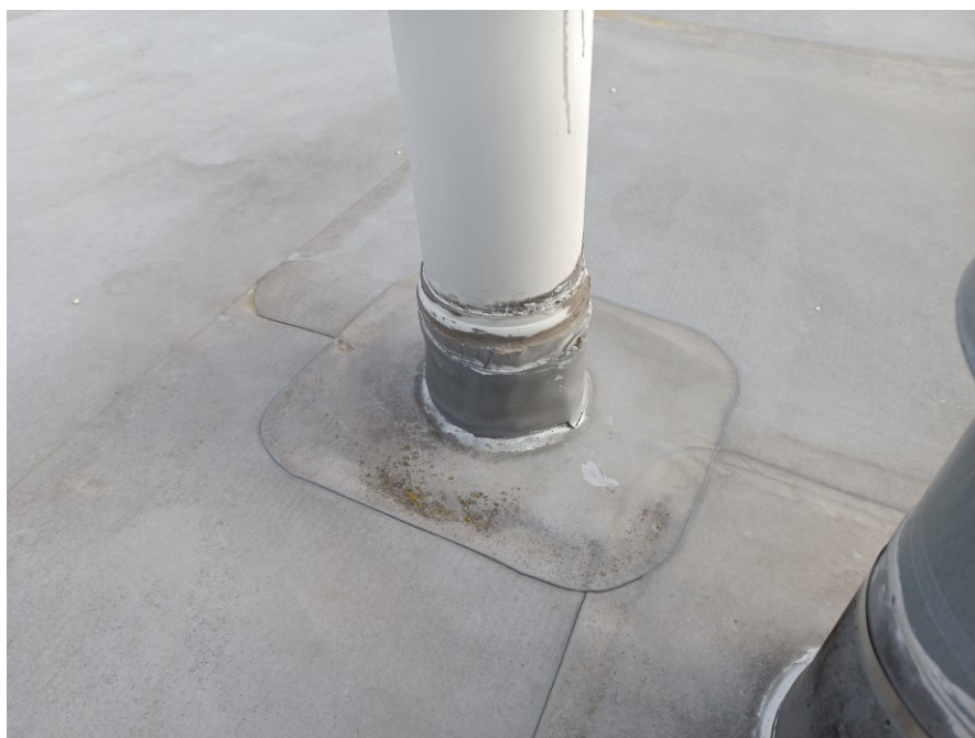
Obrázek č. 4 – Prostup VZT – poškození tmelů a lemů
